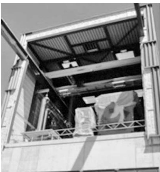
Hallenöffnung zum Einbringen der Maschinenkomponenten.
