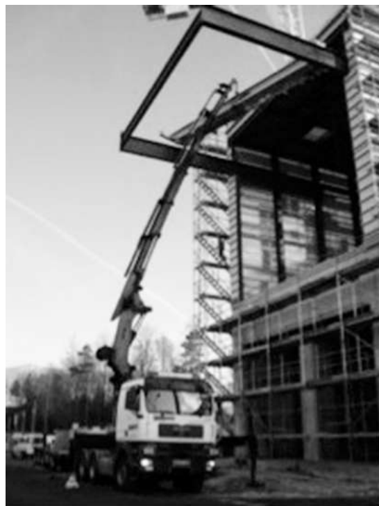
Montage der ersten Kranbrücke.
