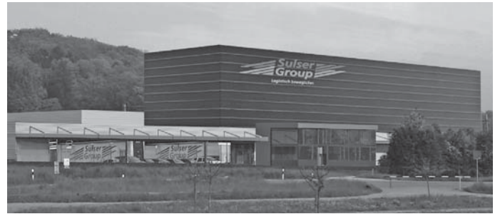
Das Logistikzentrum der Sulser Group: Nach umfangreicher Modernisierung ist am Standort Brunegg (AG) eine der modernsten Logistikplattformen in der Schweiz entstanden.
