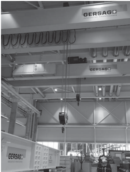
Die zwei Brückenkräne mit der 60 Tonnen Lasttraverse.
