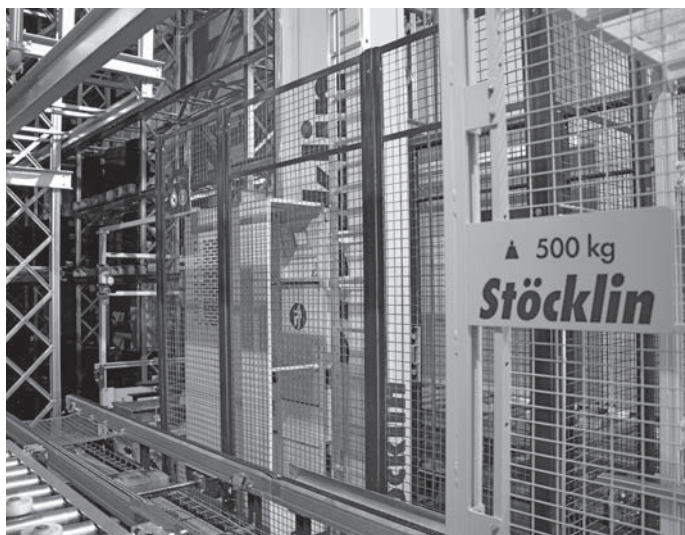
Sämtliche Funktionsbereiche im Pneulager sind komplett umwehrt.
