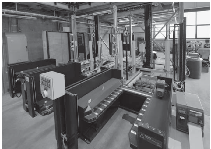
Im Erdgeschoss werden die Ladeeinheiten mit Hilfe von Handgabelhubwagen und einer speziellen Hubeinrichtung auf die als Kettenförderer ausgeführte Palettenfördertechnik übergeben.
