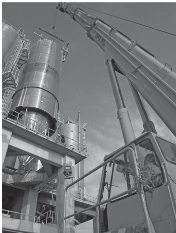
Abb. 1: Sind Wägemodule in Tragwerken aus Stahl oder Aluminium verbaut, müssen auch diese gemäss den Anforderungen der EN 1090 gefertigt sein, also die entsprechende CE-Kennzeichnung aufweisen.
