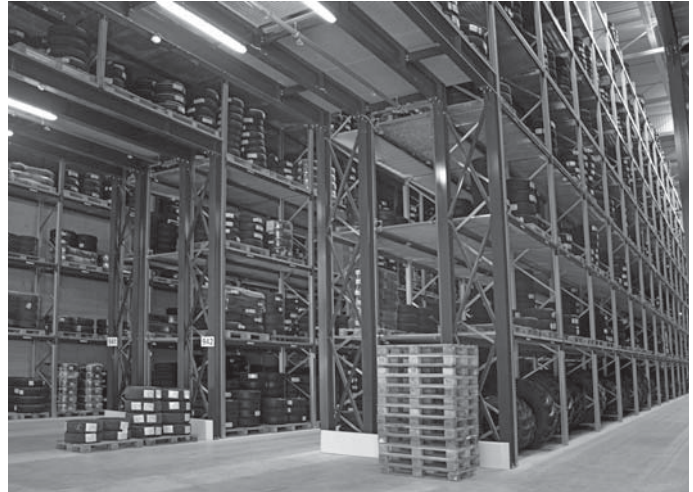
Das 4-gassige Staplerlager ist mit rund 5 700 Stellplätzen für Paletten ausgerichtet und wird mit manuell geführten Schmalgangstaplern bedient.
