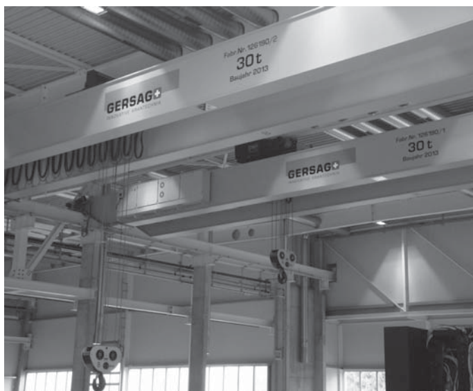
Zwei mal 30 Tonnen Zweiträger-Brückenkrane.
